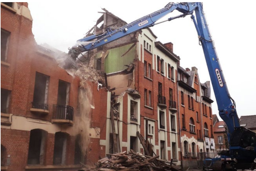
Démolition Van Droogenbroeck
