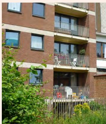
Travaux de rénovation des bétons des balcons des immeubles. Les travaux ont eu pour objet : le décapage des bétons abîmés, le traitement des armatures, les réparations et la protection des bétons.
