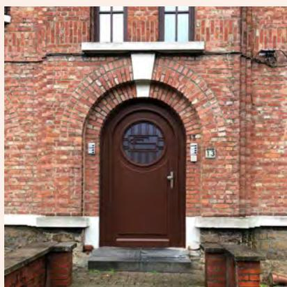
Remplacement à l'identique des anciens châssis simple vitrage par des châssis performants à double vitrage en bois. Ce plan de remplacement de châssis a permis l'amélioration du confort et des performances énergétiques des logements.
