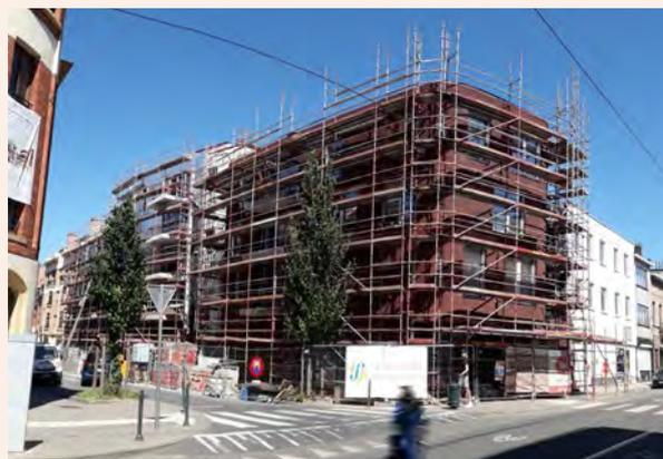
**En 2020, le chantier s'est poursuivi : pose des châssis, finalisation du parement en briques, réalisation des techniques et parachèvement.** Ce projet a été récompensé dans l'édition 2016 de l'appel à projets « Be-Exemplary, bâtiments bruxellois exemplaires ».
