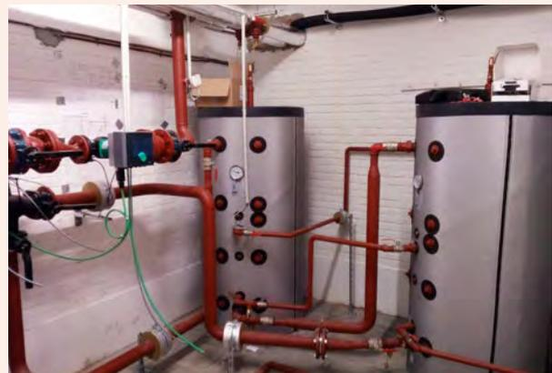
Remplacement de l'ancienne chaudière au mazout par une chaudière au gaz et suppression des chauffe-bains individuels remplacés par une production d'eau chaude sanitaire centralisée.
