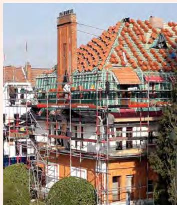
Rénovation et isolation complète « à l'identique » des toitures en tuiles de 9 immeubles de la cité Terdelt. Ces toitures, qui dataient de la construction des immeubles (années 1920), n'ont jusqu'à aujourd'hui fait l'objet que de petites réparations ponctuelles.
